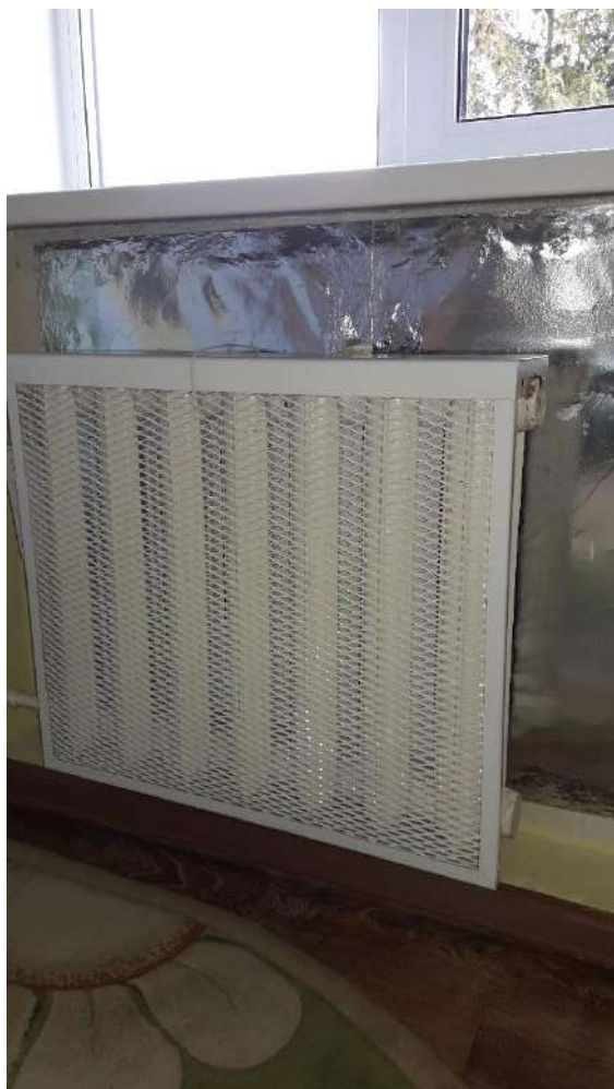
Фото 3 Батареи в кабинетах
