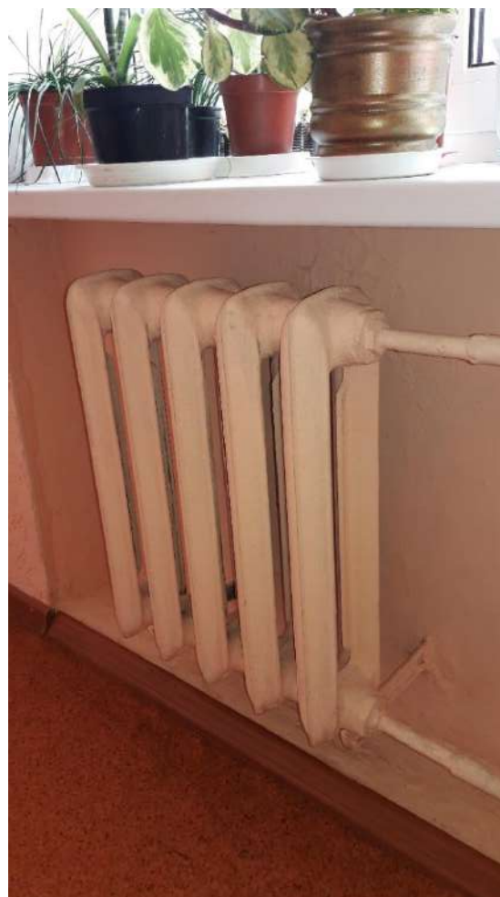
Фото 4 Батареи в подсобных помещениях
